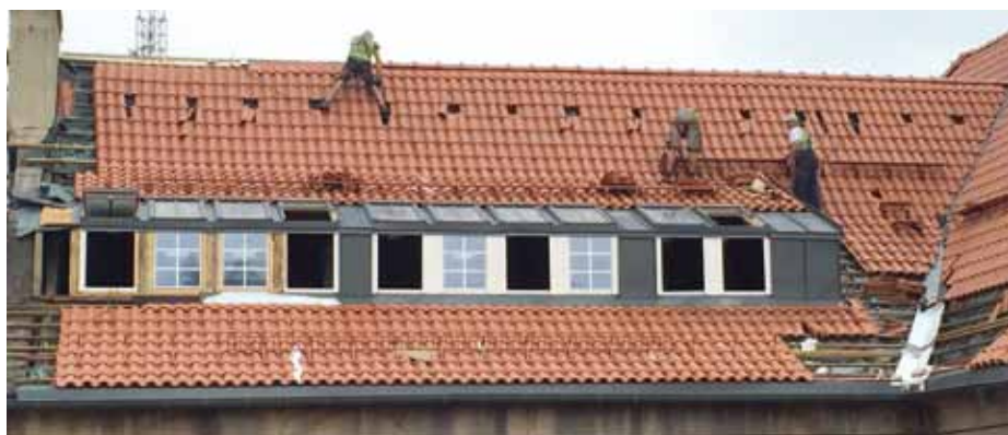
▲ Nowe okna, nowe lukarny, nowe pokrycie
