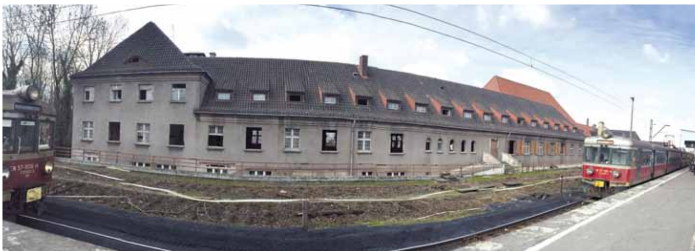
▲ Ta część budynku sugeruje, że dach był prosty i łatwy...
