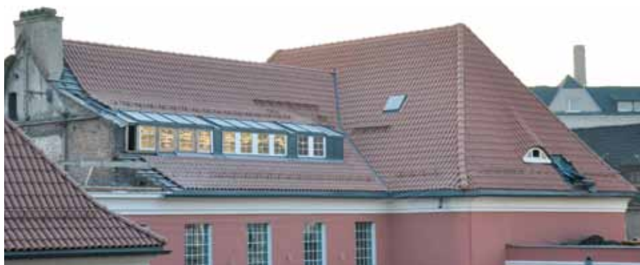
▲ Dach prawie na gotowo
