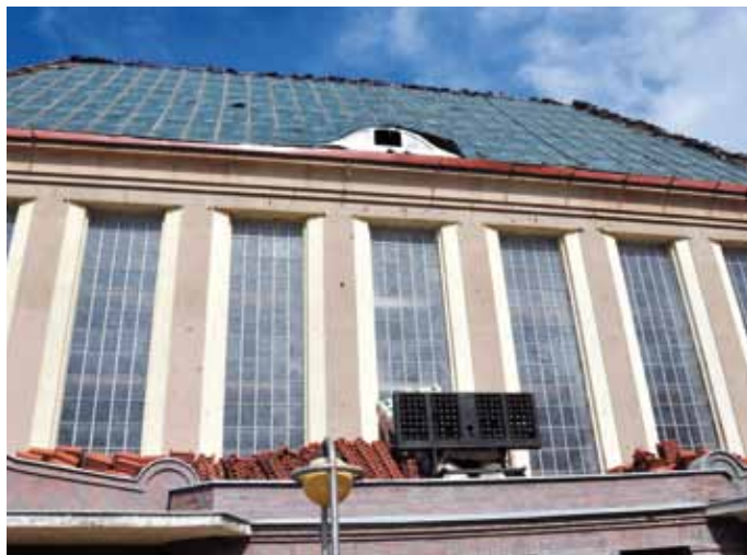
▲ Dach „dominany” z membraną. Na dole widać starą dachówkę, wyczyszczoną i przygotowaną do ponownego ułożenia
