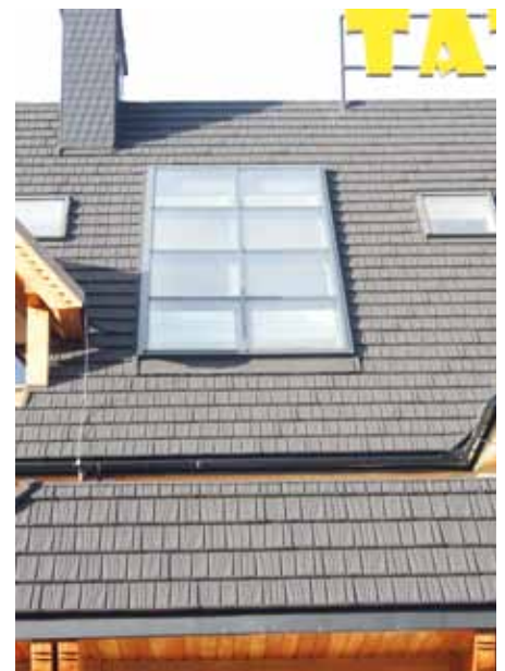
▲ Wszystkie fabryczne kotnierze Fakro zastąpiono warsztatowymi obróbkami
