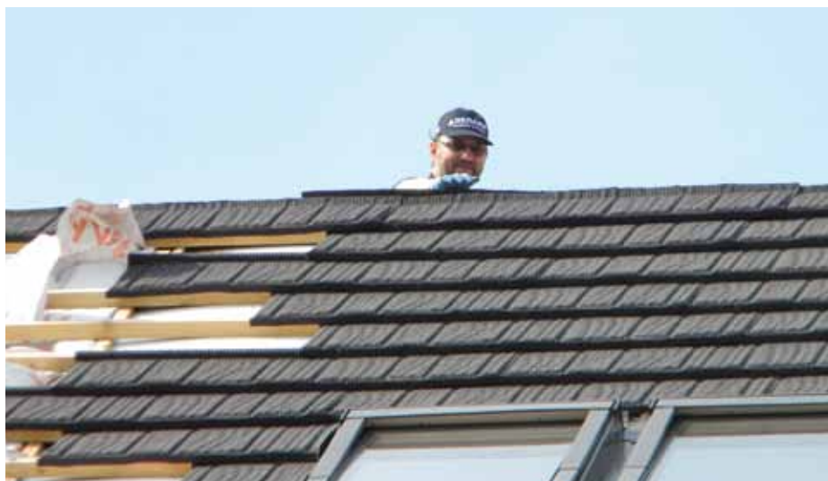
▲ Krycie dachu rozpoczęto od strony tylnej
