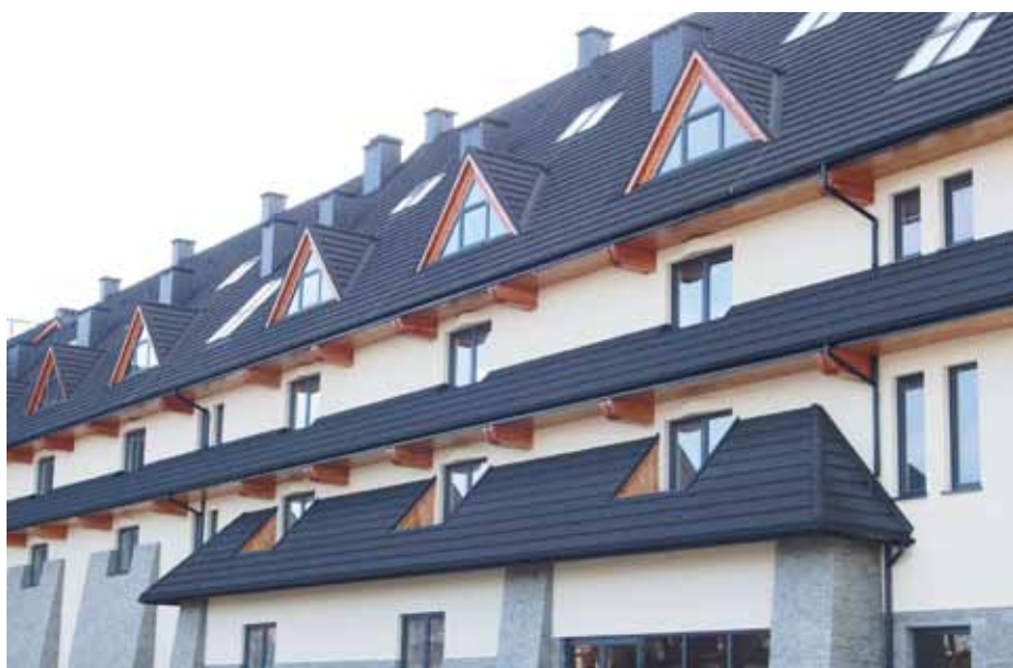
▲ Nie ma tu płotków przeciwniegowych, ponieważ projektant uznał, że szorstka powierzchnia pokrycia przytrzyma śnieg
