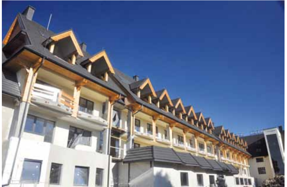
▲ 105 okien dachowych Fakro, 30 lukarn, 26 kominów – nic dziwnego, że prace na dachu trwały 8 miesięcy
